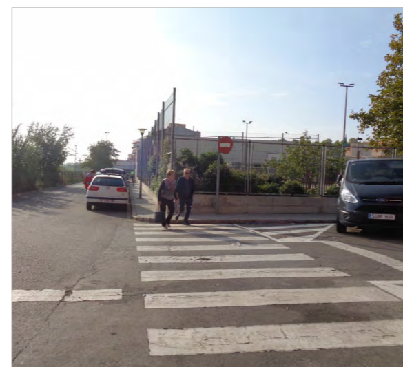
Pas de vianants al c/ Joan Mates no accessible.
