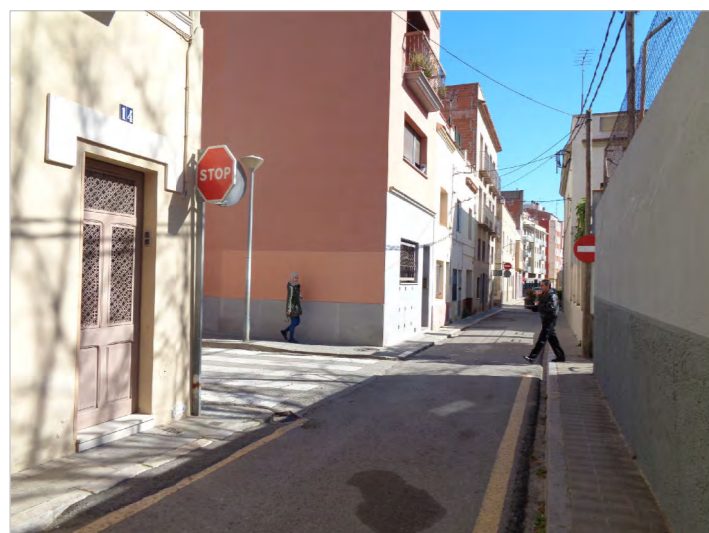
Voreres estreta i passos de vianants sense adaptar
