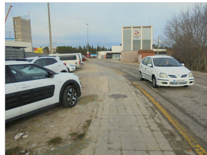
Vorera invadida pels vehicles i en mal estat.
